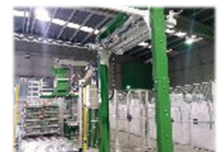
Banderolage de sacs de ciment
